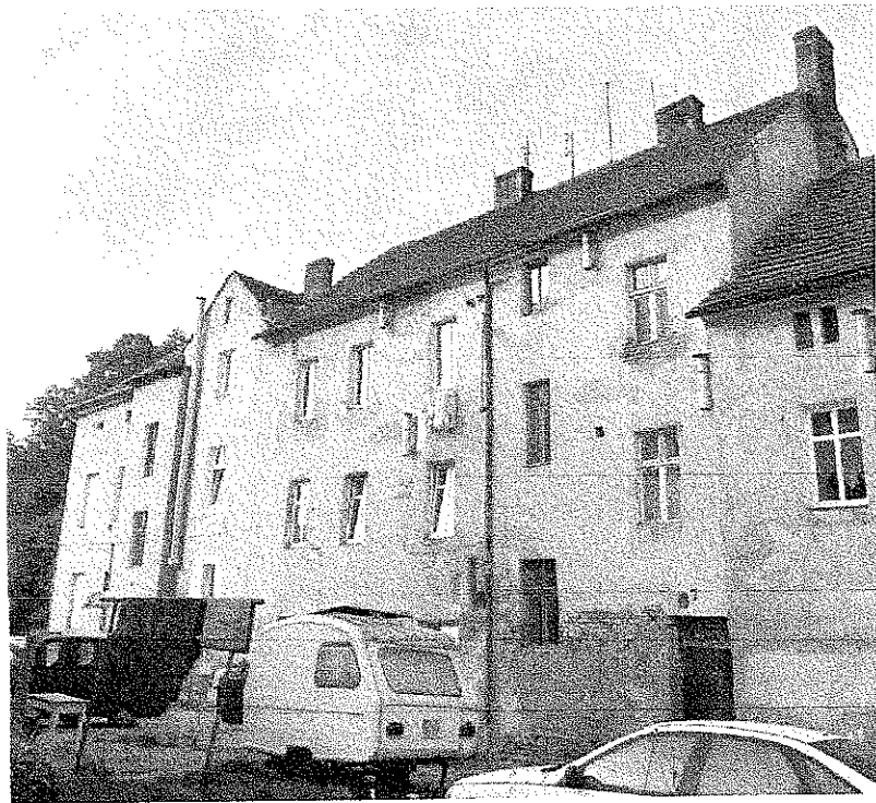
Zdjęcie nr 2 – Dach od strony podwórza
