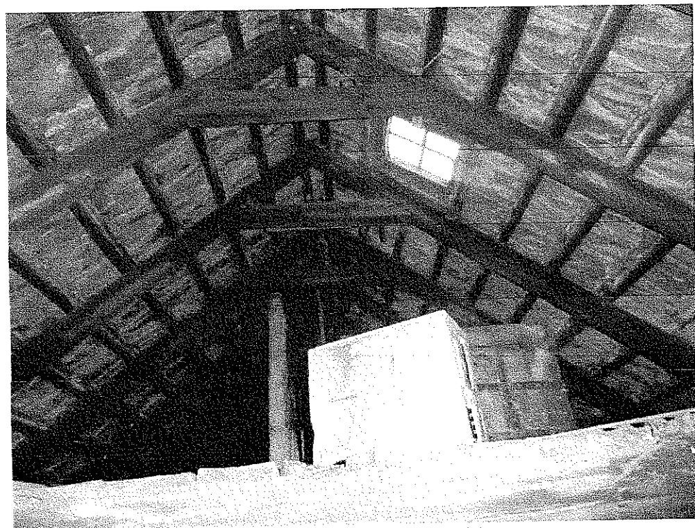
Zdjęcie nr 3 – II poziom poddasza
