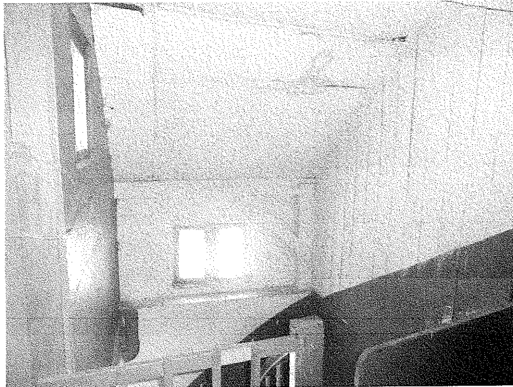
Zdjęcie nr 6 – Zawilgocona podsufitka na I poziomie poddasza
