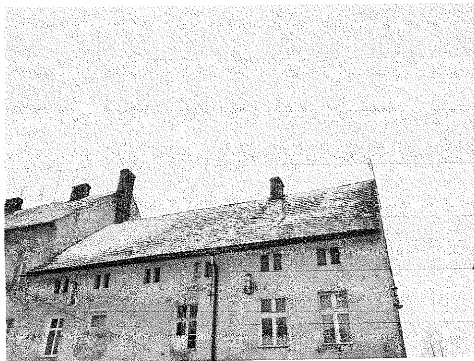
Zdjęcie nr 2 – Dach od strony podwórza
