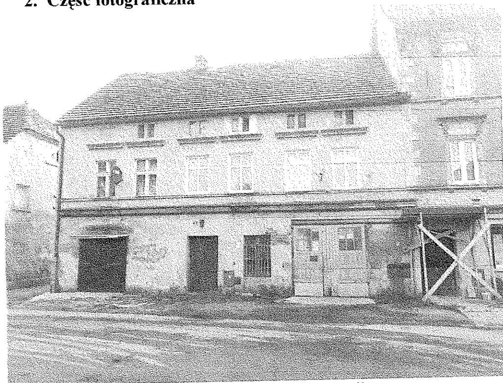
Zdjęcie nr 1 – Dach od strony ulicy
