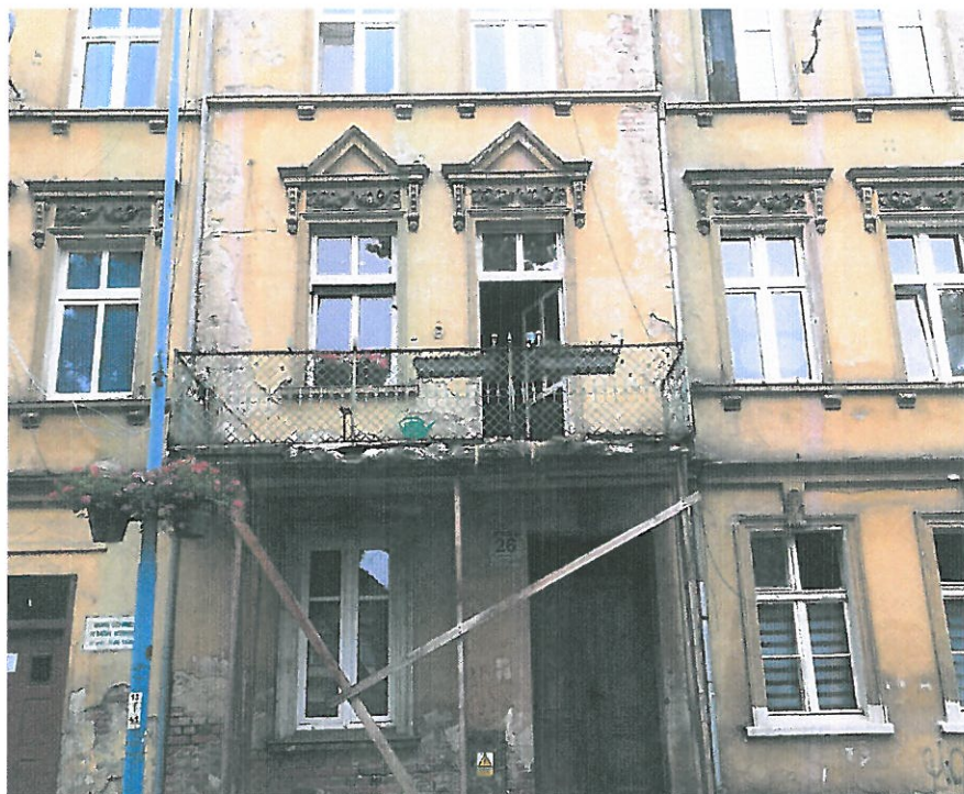
Zdjęcie nr 1 – Widok balkonu
