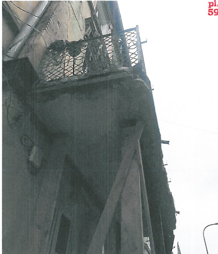
Zdjęcie nr 2 – Widok płyty balkonu od dołu
