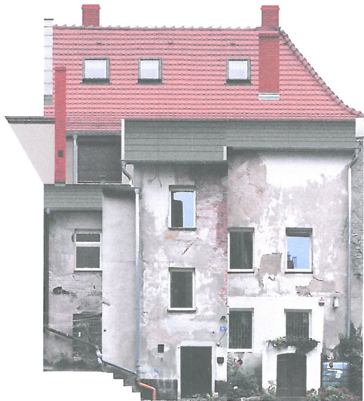
Widok elewacji podwórzowej.
