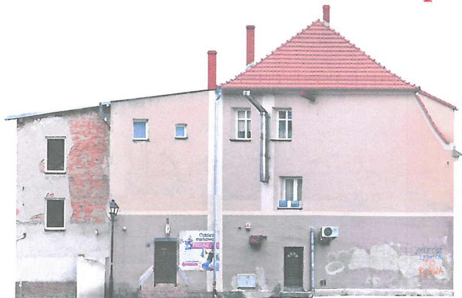
Widok elewacji szczytowej.
