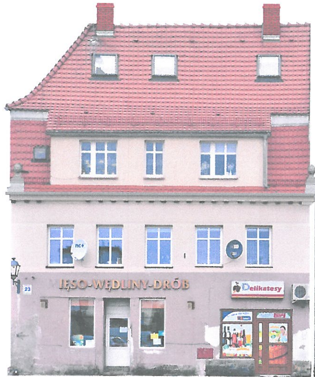
Widok elewacji frontowej.
