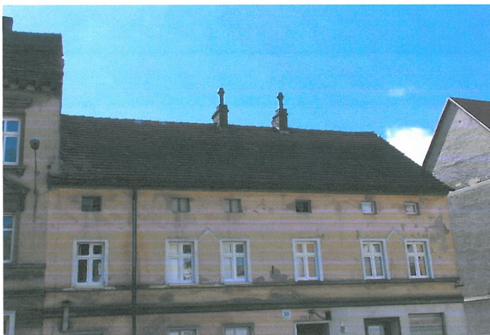
Zdjęcie nr 1 – Połąć dachu północna
