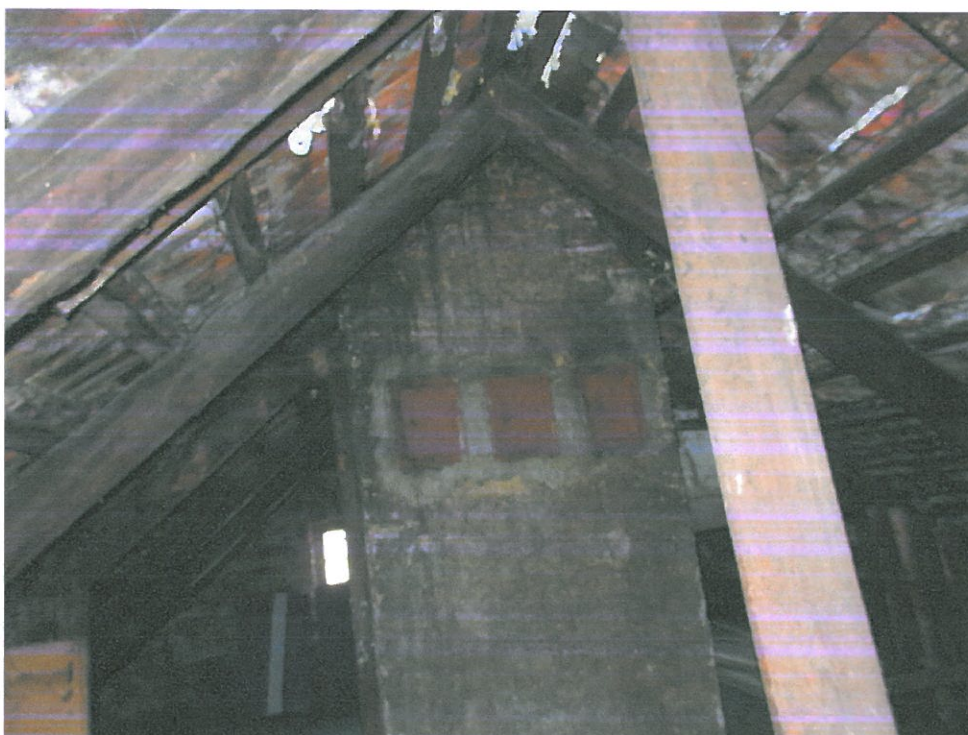
Zdjęcie nr 5 – II poziom poddasza, komin
