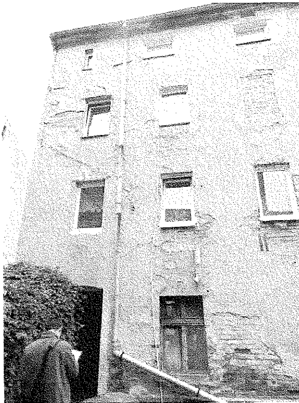
Zdjęcie nr 1 – Elewacja od strony podwórza
