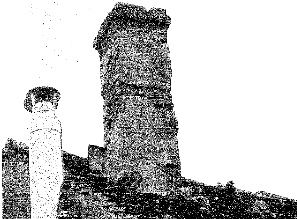
Zdjęcie nr 6 – Uszkodzone i pozbawione tynku kominy ponad dachem
