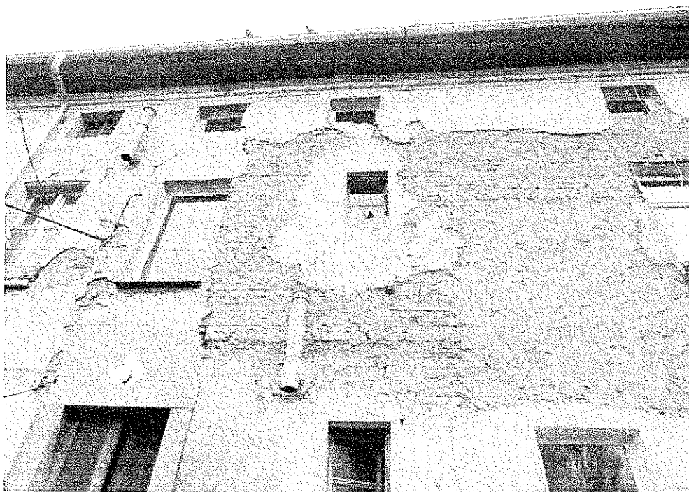
Zdjęcie nr 4 –Pęknięcia i rysy na elewacji tylnej
