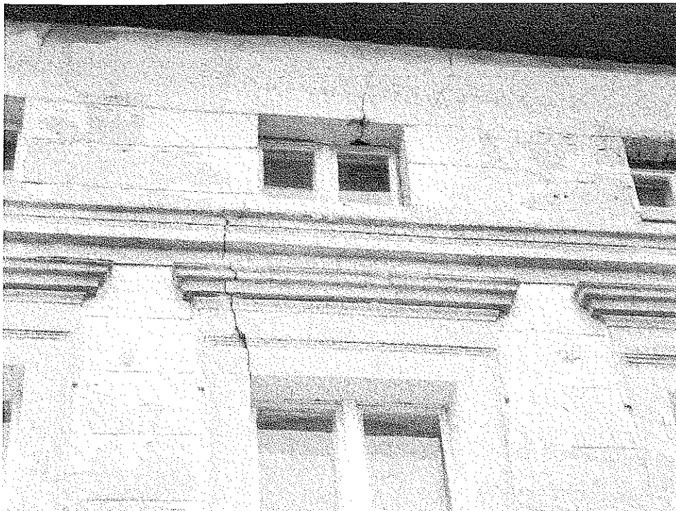
Zdjęcie nr 4 –Pęknięcia i rysy na elewacji frontowej
