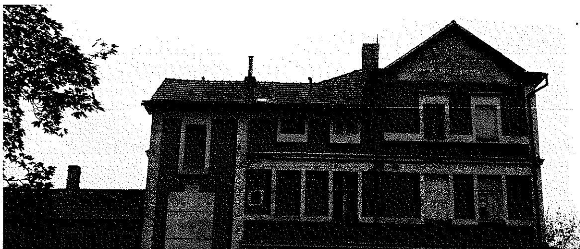
Zdjęcie nr 2 – Dach od strony podwórza
