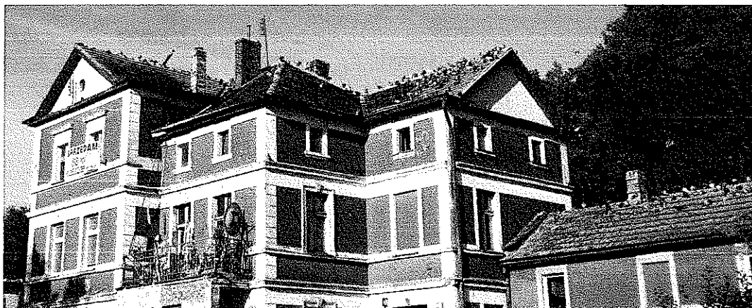
Zdjęcie nr 1 – Dach od strony ulicy
