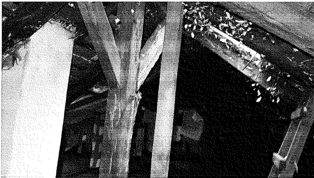
Zdjęcie nr 8 – Uszkodzony słup i miecze na II poziomie poddasza
