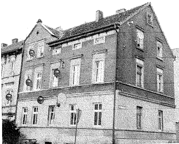
Zdjęcie nr 1 – Dach od strony ulicy
