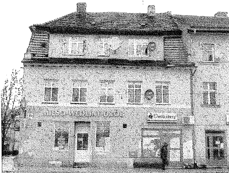
Zdjęcie nr 1 – Dach od strony ulicy
