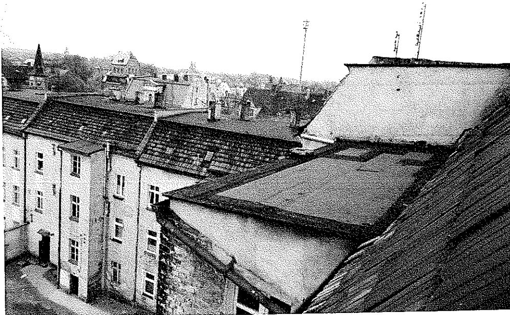
Zdjęcie nr 6 – Dach przybudówki
