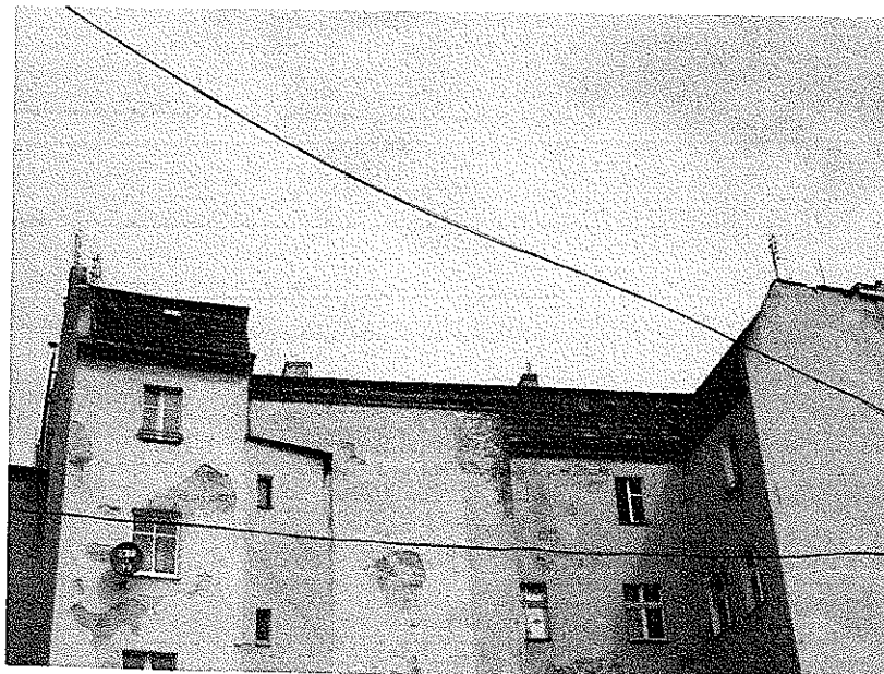
Zdjęcie nr 2 – Dach od strony podwórza
