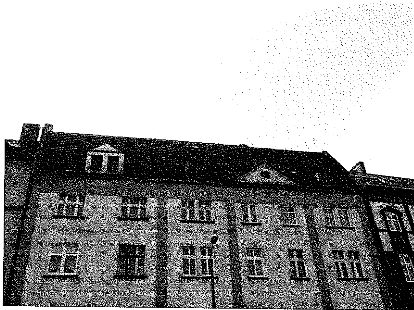
Zdjęcie nr 1 – Dach od strony frontowej
