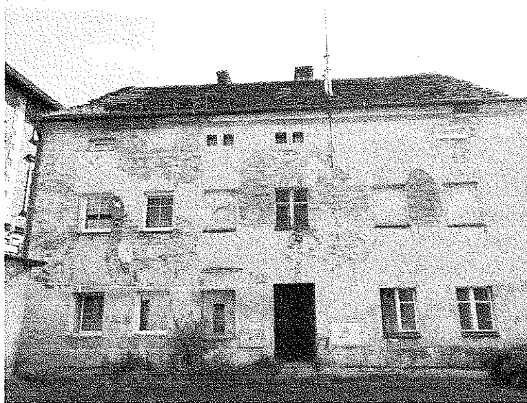
Zdjęcie nr 1 – Elewacja od strony podwórza
