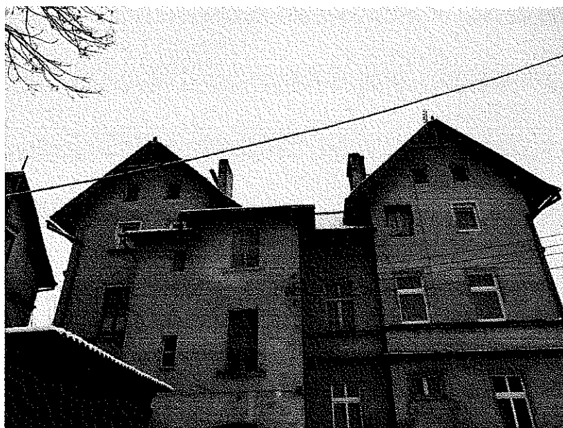
Zdjęcie nr 2 – Dach od strony podwórza
