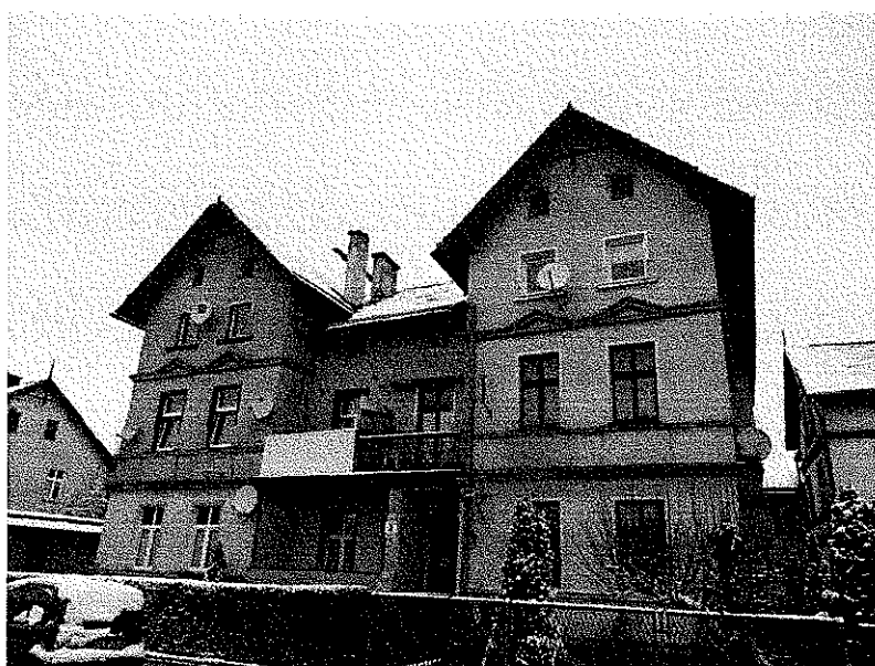
Zdjęcie nr 1 – Dach od strony ulicy
