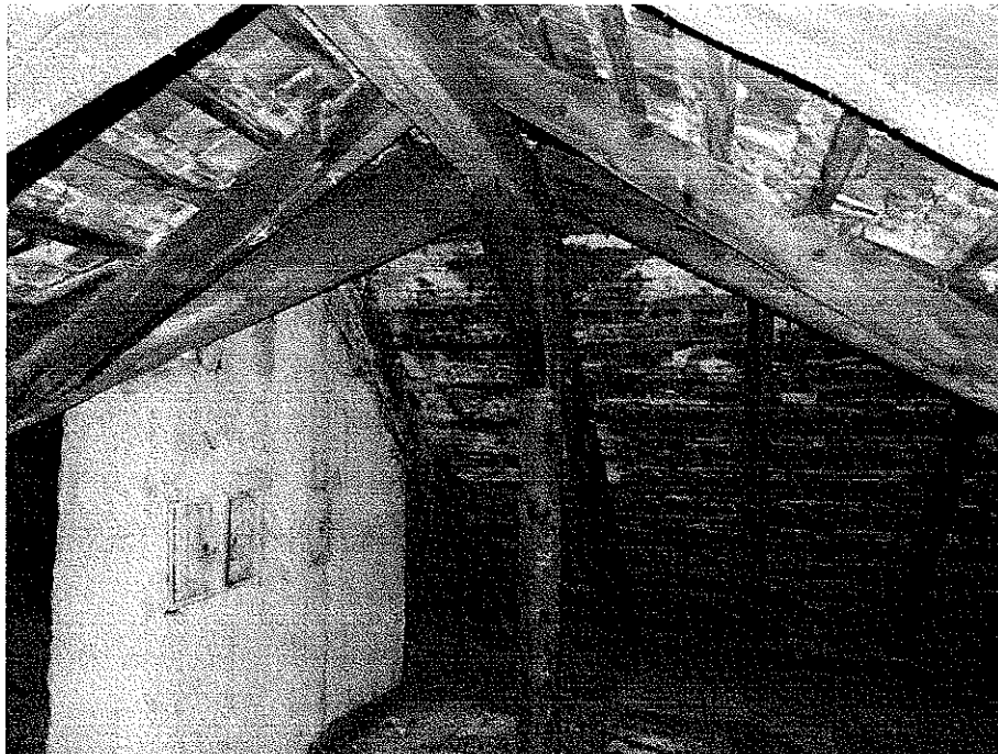
Zdjęcie nr 3 – Widok więźby dachowej
