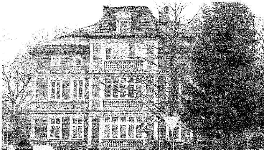
Zdjęcie nr 1 – Dach od strony ulicy
