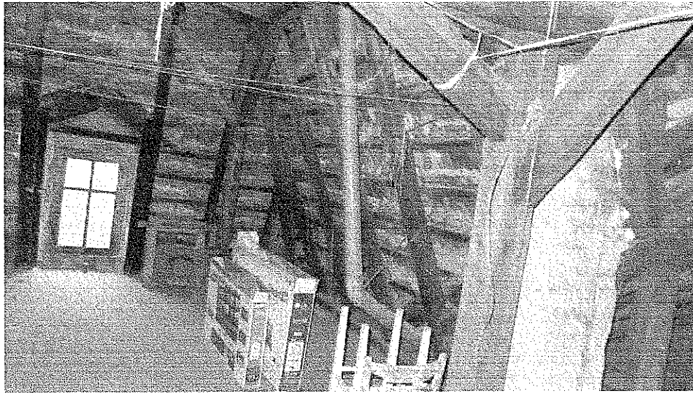
Zdjęcie nr 3 – Widok konstrukcji dachu
