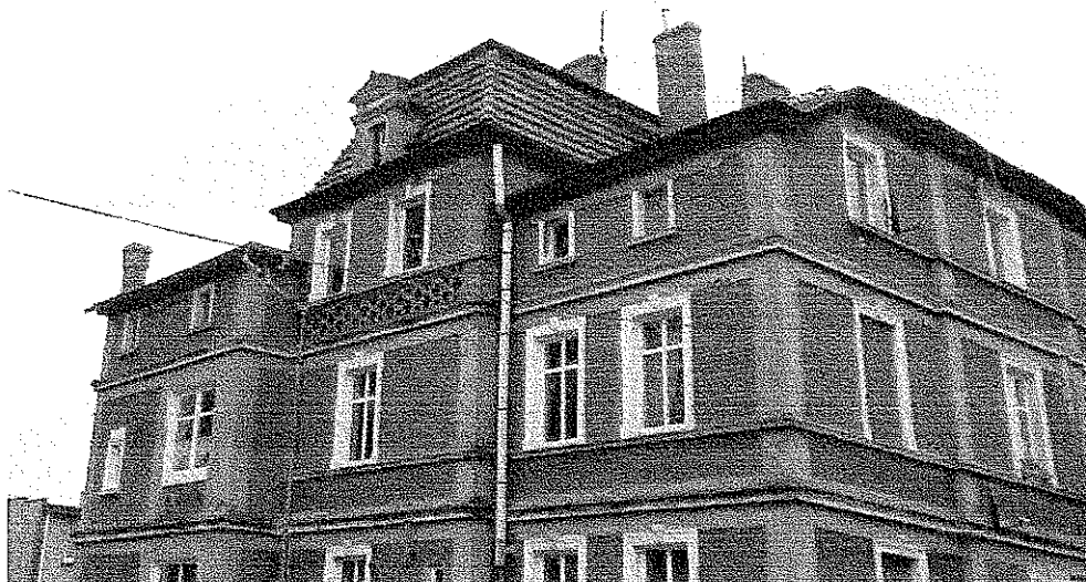
Zdjęcie nr 2 – Dach od strony podwórza
