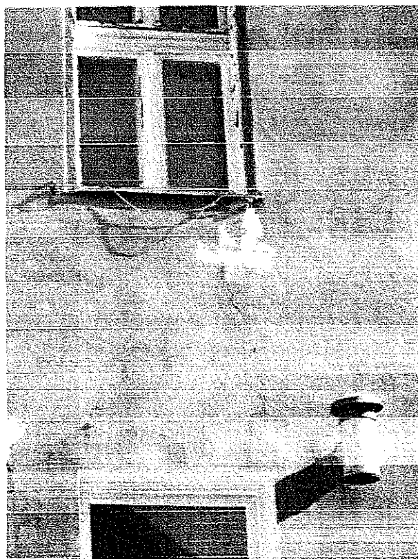
Zdjęcie nr 5 – Elewacja od strony podwórza
