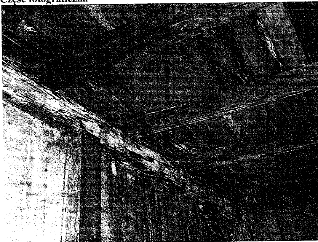
Zdjęcie nr 1 – Więźba dachowa
