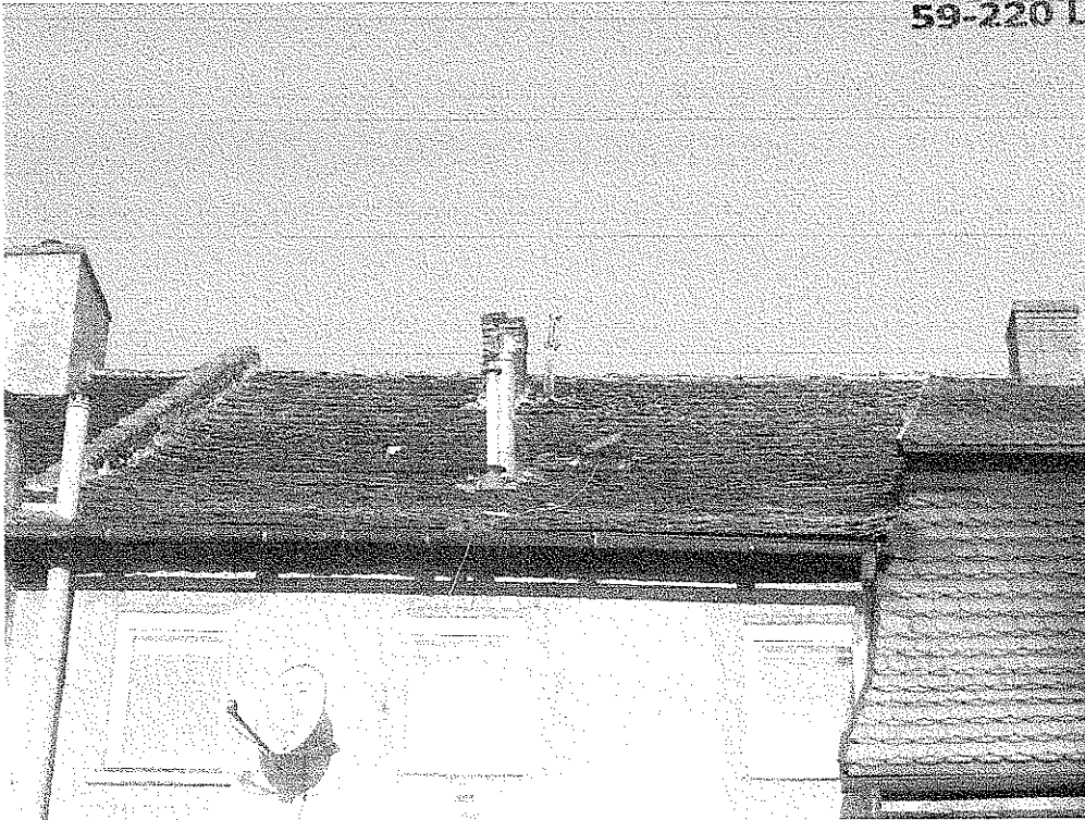
Zdjęcie nr 2 – Dach od strony podwórza
