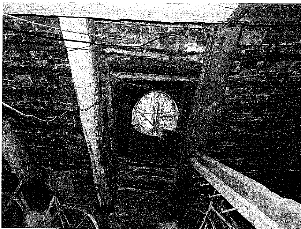
Zdjęcie nr 5 – I poziom poddasza – lukarna metalowa
