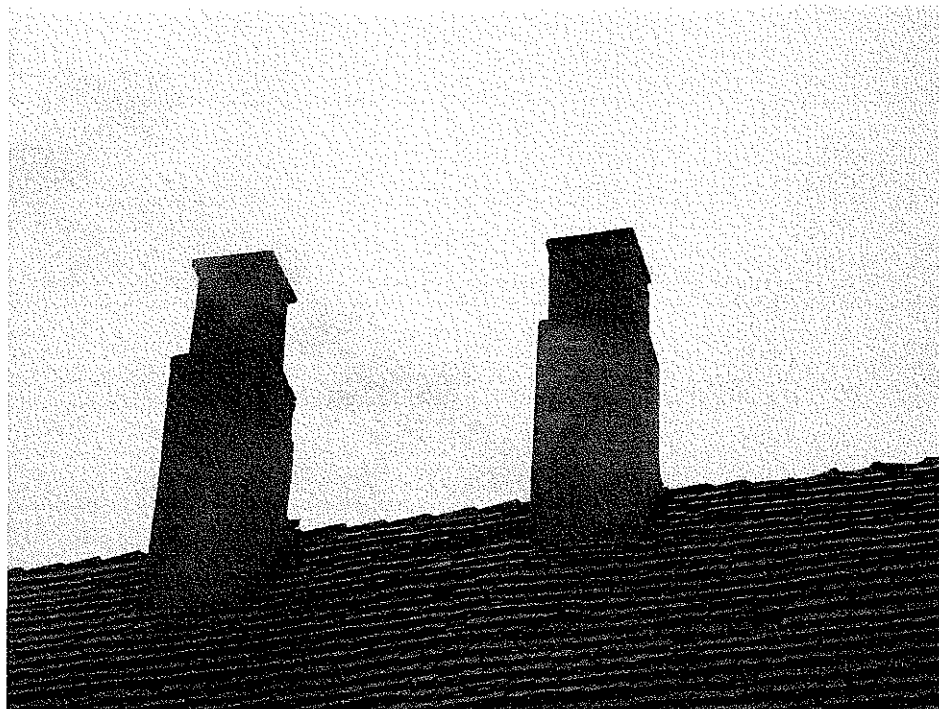
Zdjęcie nr 4 – Uszkodzone i pozbawione tynku kominy ponad dachem
