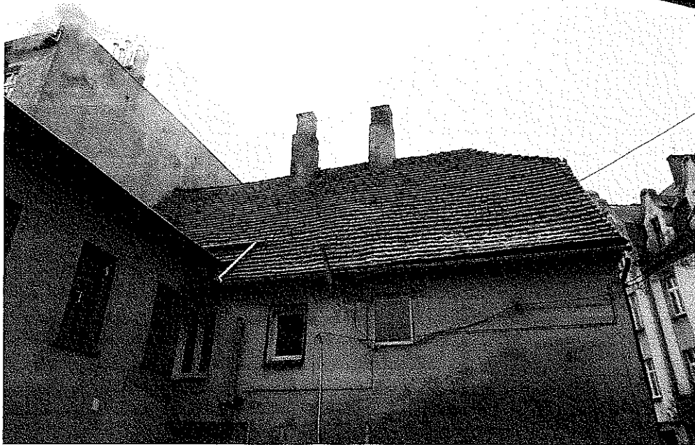
Zdjęcie nr 2 – Dach od strony podwórza
