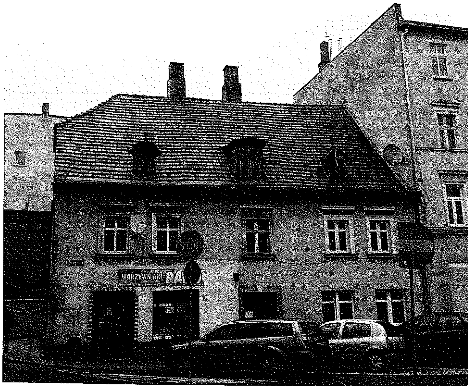
Zdjęcie nr 1 – Dach od strony ulicy
