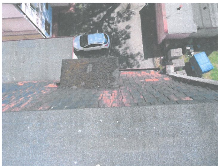
Zużyte pokrycie z papy na lukarnie od strony podwórza.
