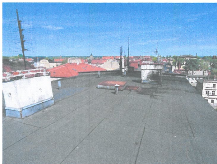
Pokrycie papowe w środkowej części dachu.
