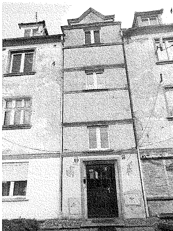
Zdjęcie nr 1 – Elewacja zachodnia
