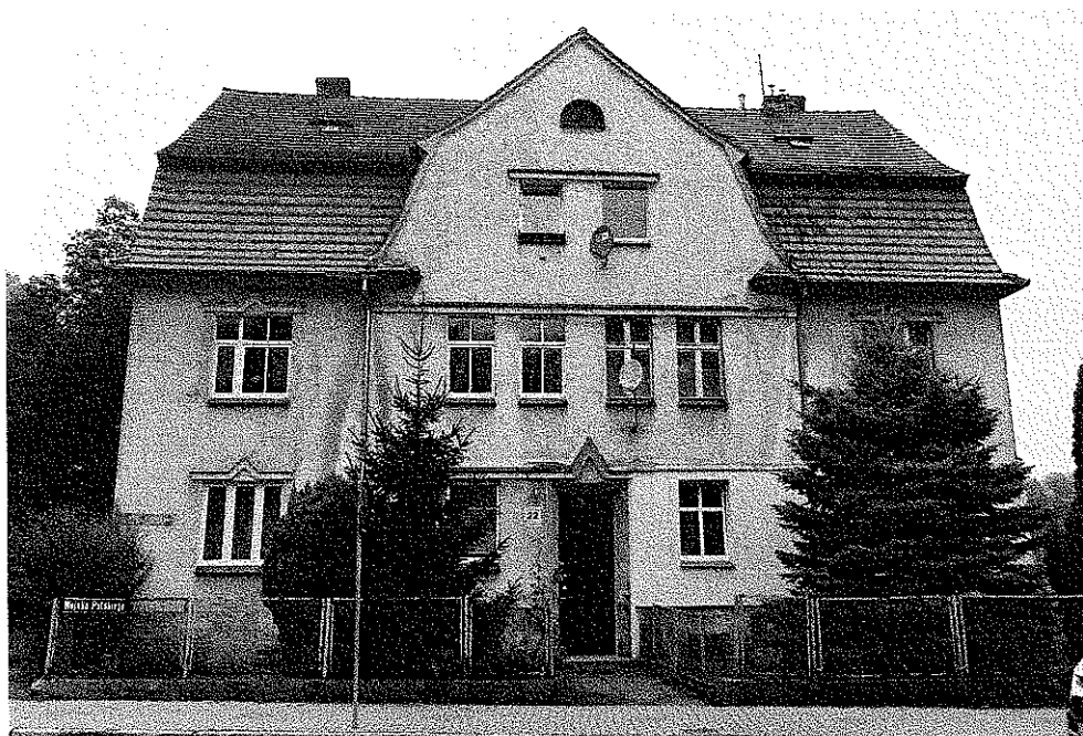
Zdjęcie nr 1 – Elewacja południowo-wschodnia
