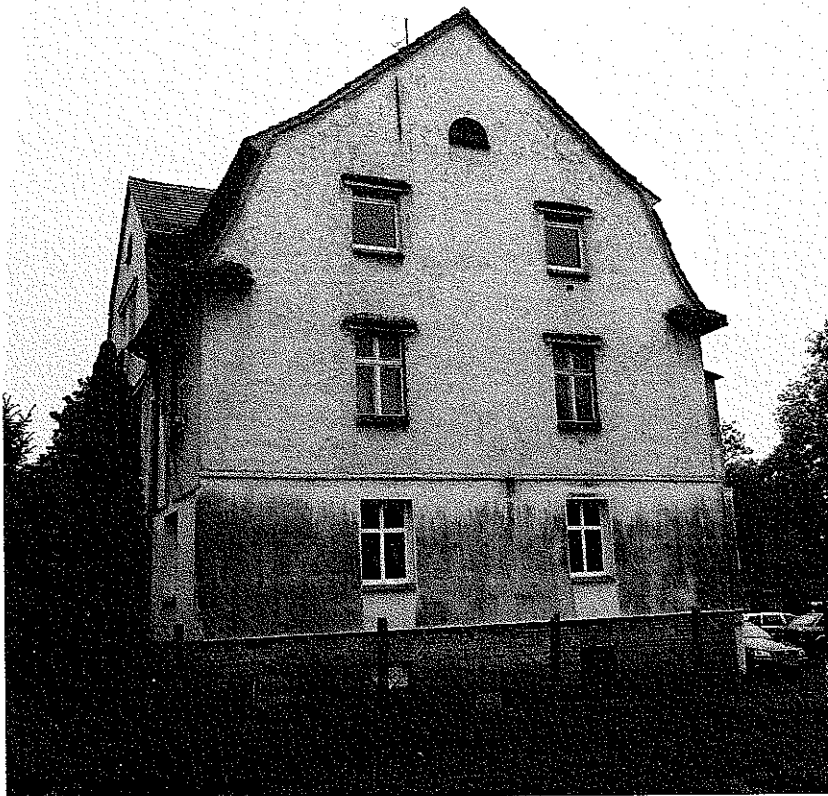
Zdjęcie nr 4 –Elewacja południowa wewnętrzna
