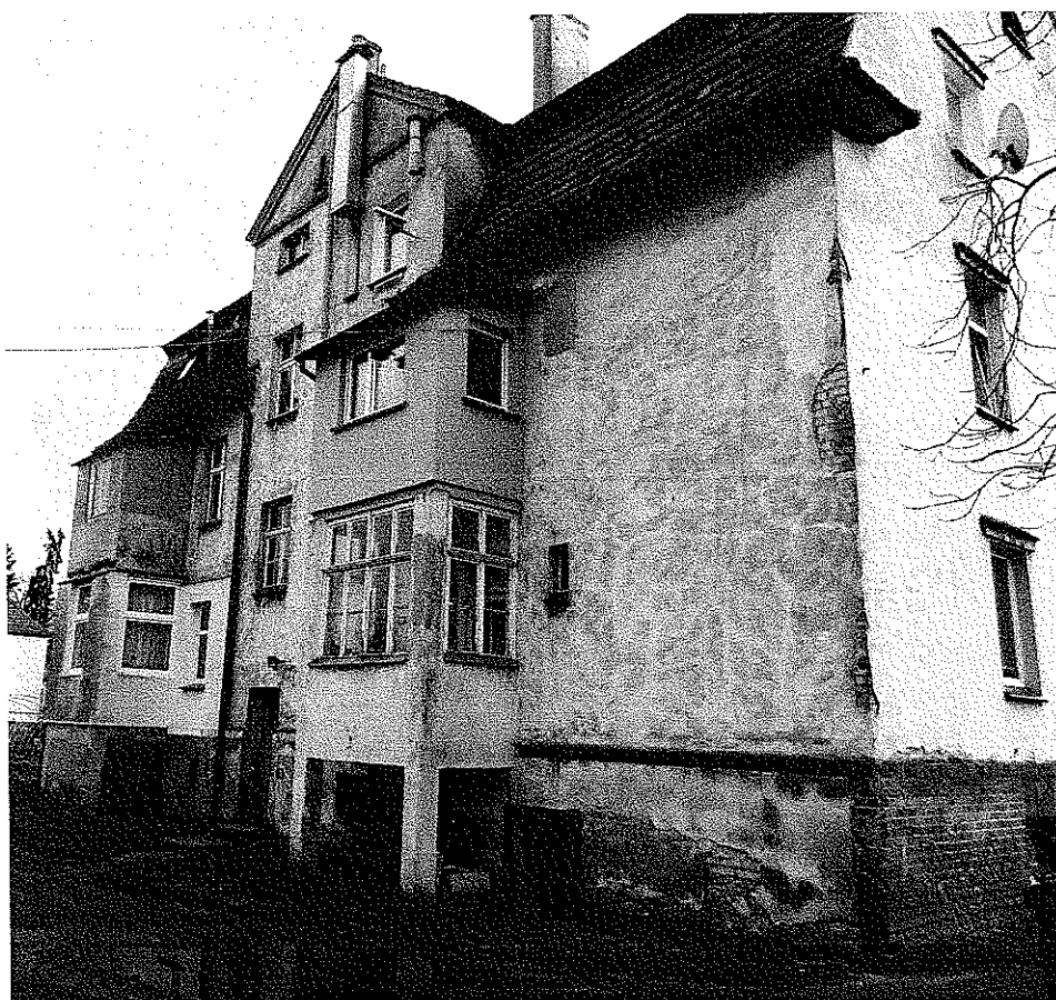
Zdjęcie nr 3 – Elewacja północno-zachodnia
