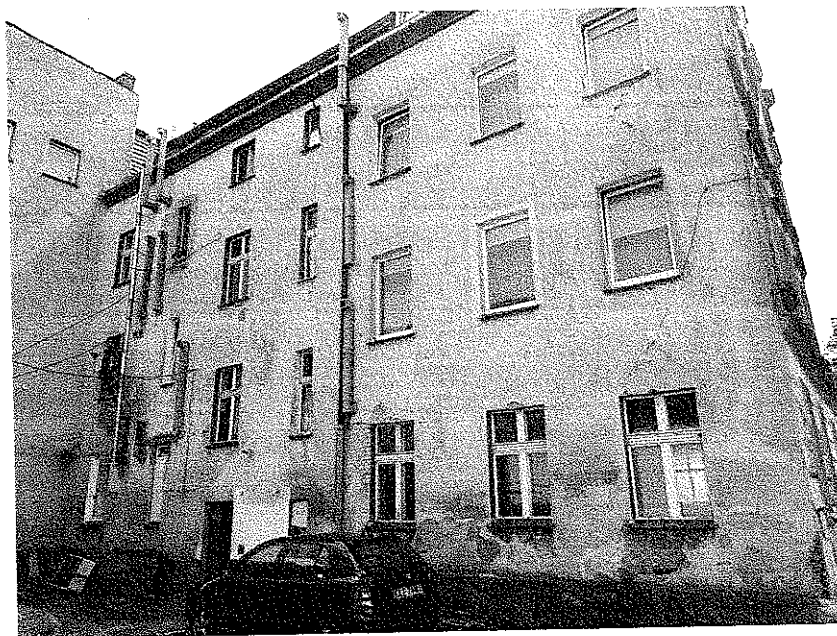
Zdjęcie nr 4 – Elewacja północna
