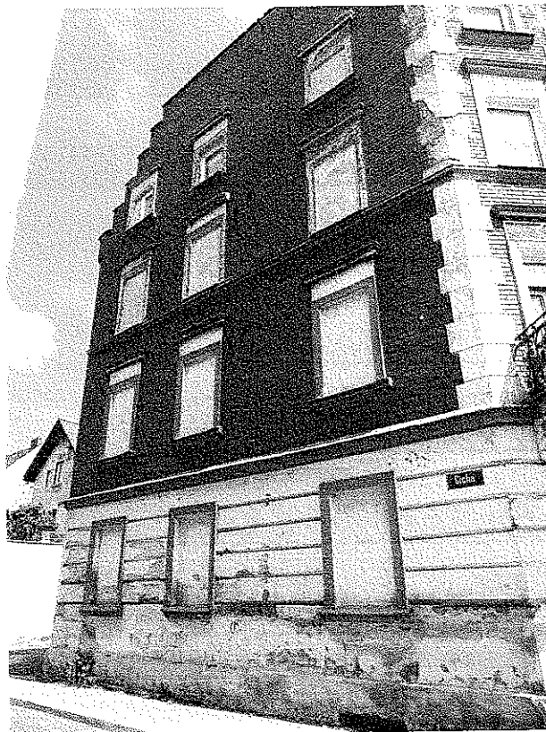
Zdjęcie nr 2 – Elewacja zachodnia
