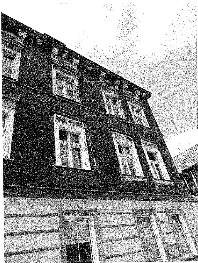
Zdjęcie nr 3 – Elewacja wschodnia
