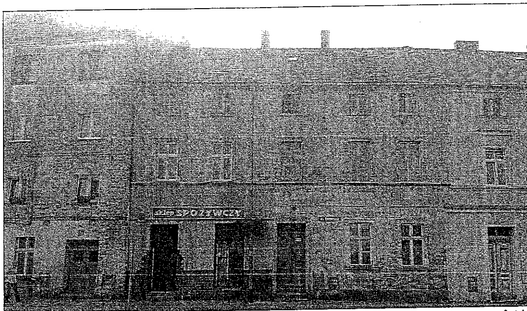
Widok ogólny budynku - elewacja frontowa:
