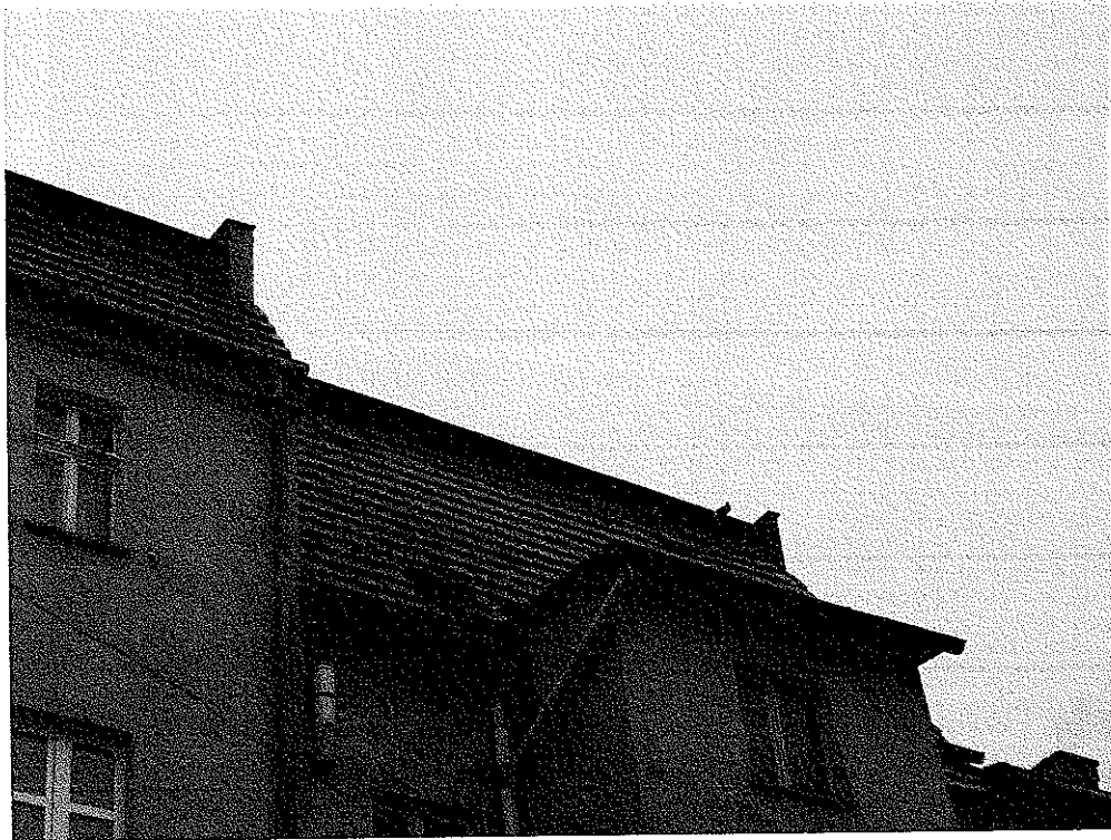
Zdjęcie nr 2 – Dach od strony podwórza
