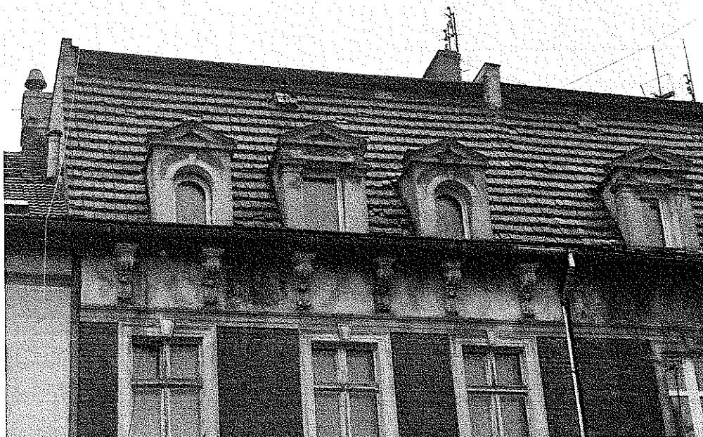
Zdjęcie nr 1 – Dach od strony ulicy
