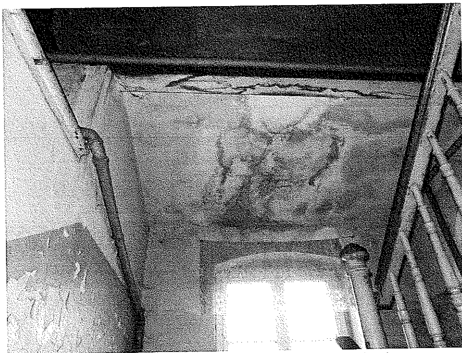
Zdjęcie nr 3 – Widok stropu nad klatką schodową
