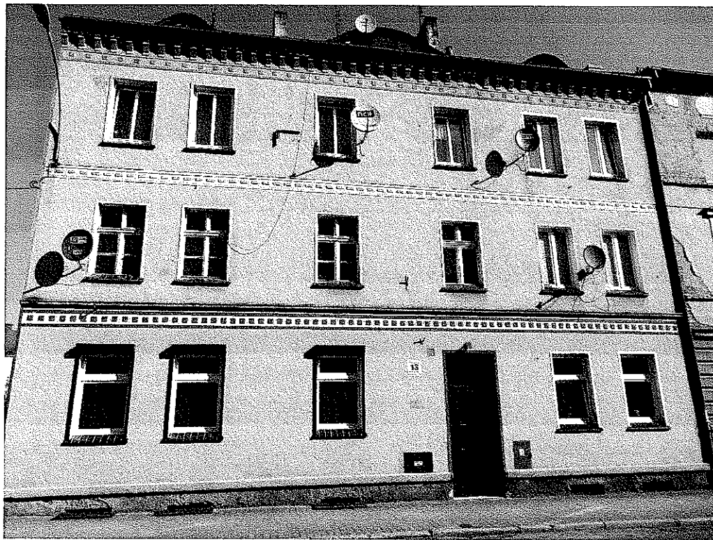
Zdjęcie nr 1 – Elewacja frontowa
