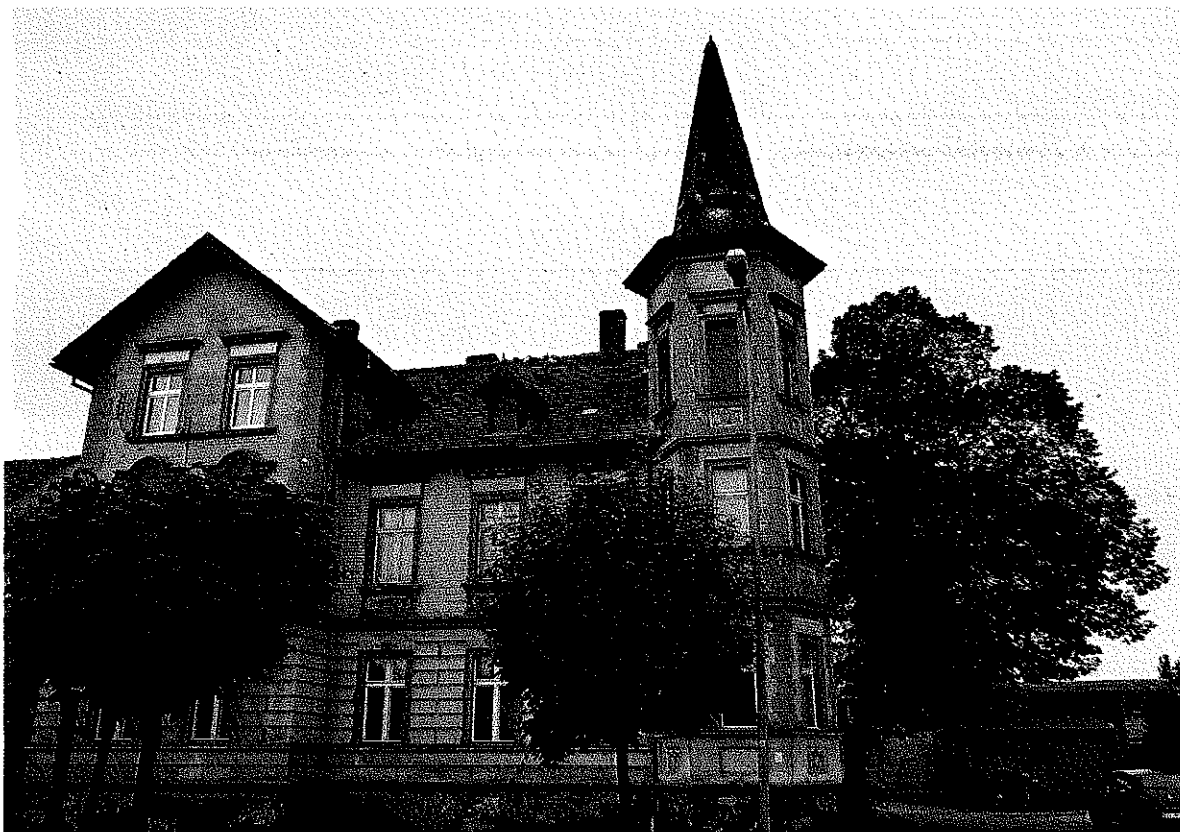
1. Widok dachu od strony ulicy
