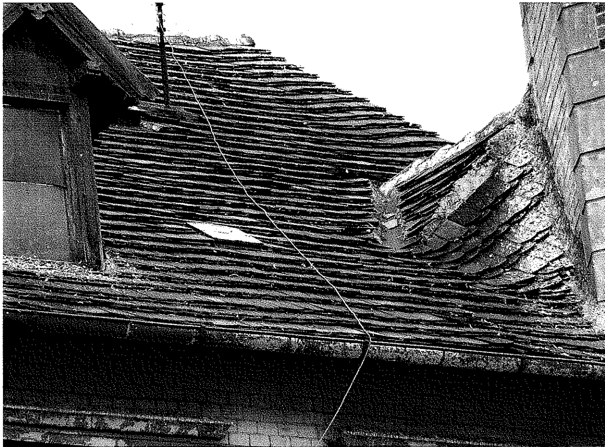
5 Grzbiet łącznika połaci dachowej z wieżą
