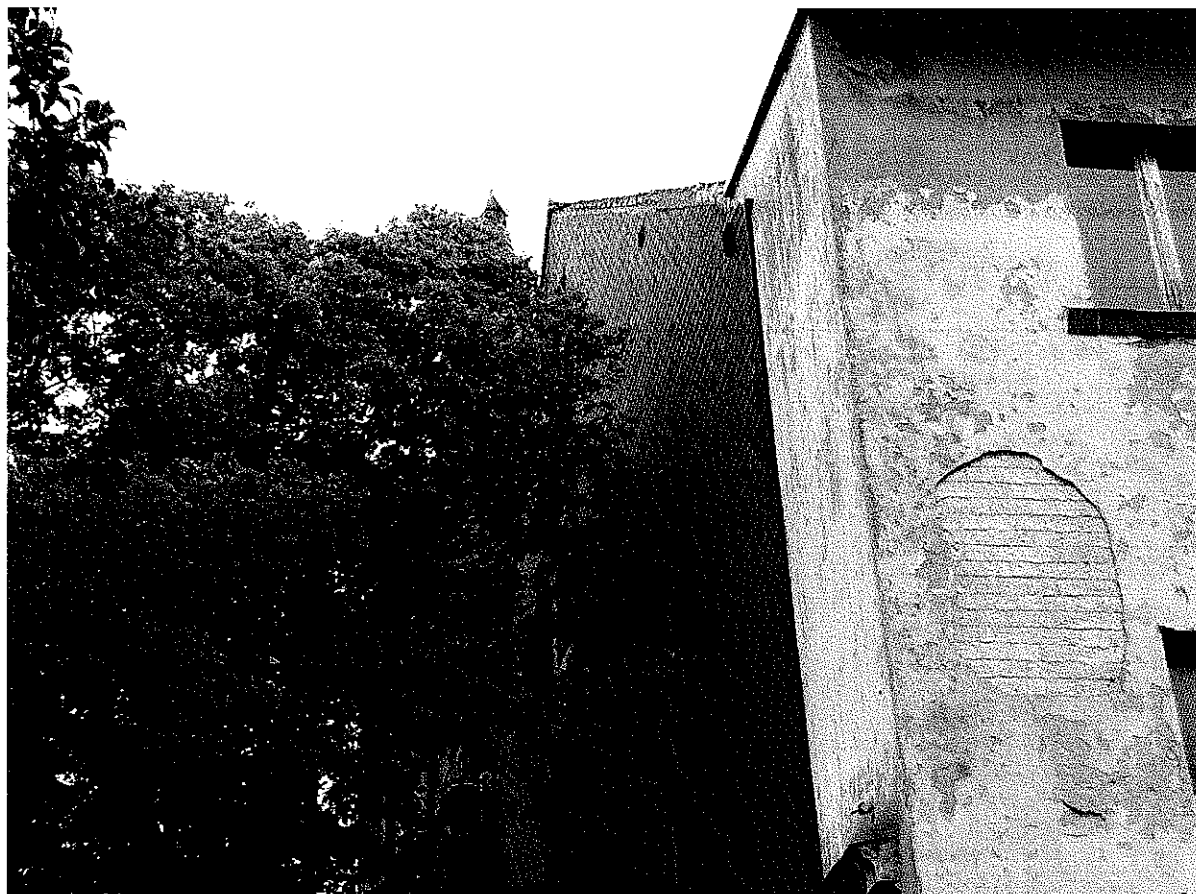
9 Brakujący okap dachu od strony nr 21
