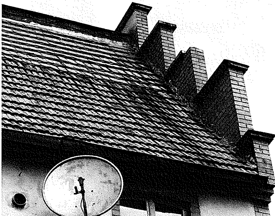
Zdjęcie nr 5 – Dach od strony podwórza
