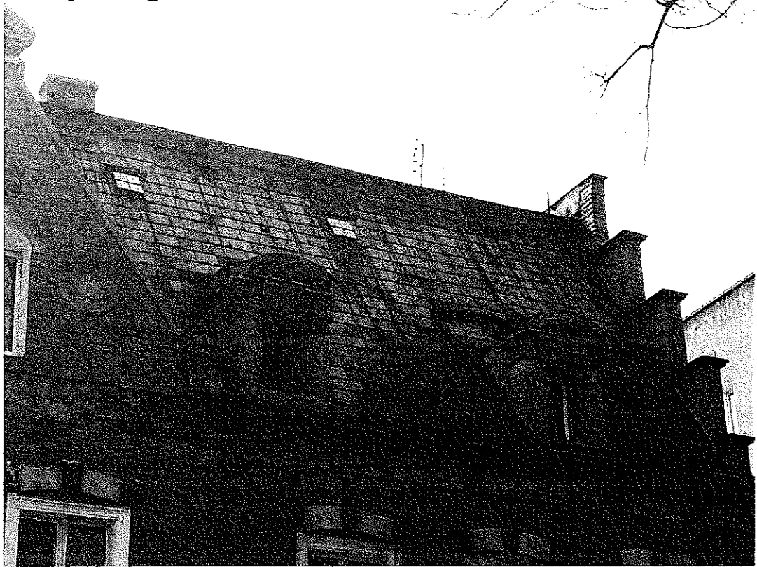
Zdjęcie nr 1 – Dach od strony ulicy Reja
