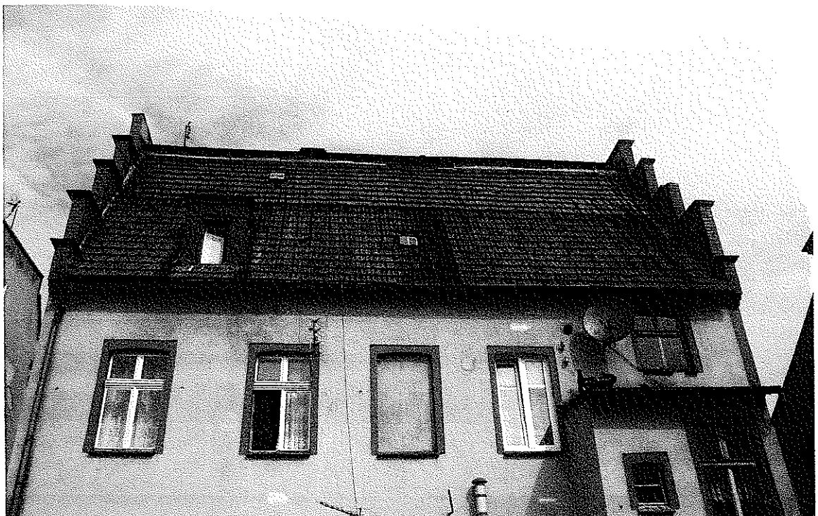
Zdjęcie nr 4 – Dach od strony podwórza
