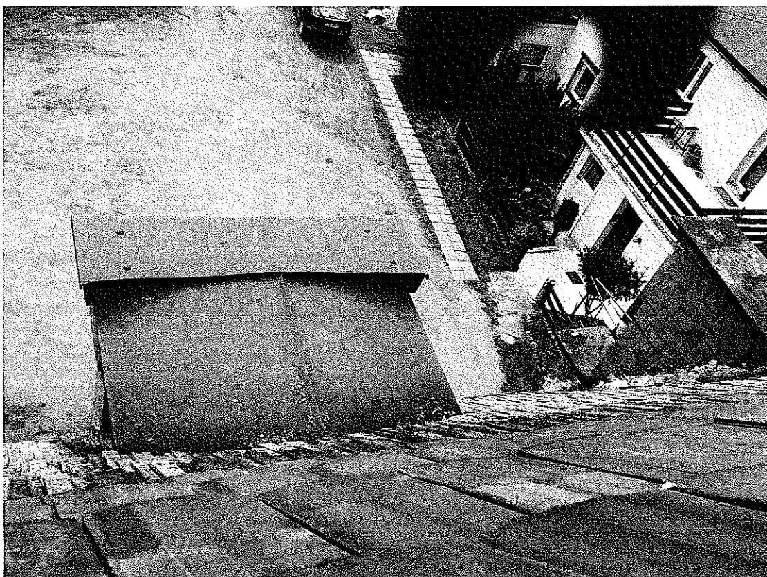
Zdjęcie nr 6 – Dach od strony podwórza
