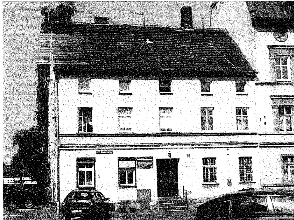
Zdjęcie nr 1 – Elewacja frontowa
