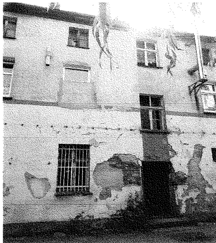
Zdjęcie nr 2 – Elewacja od podwórza
