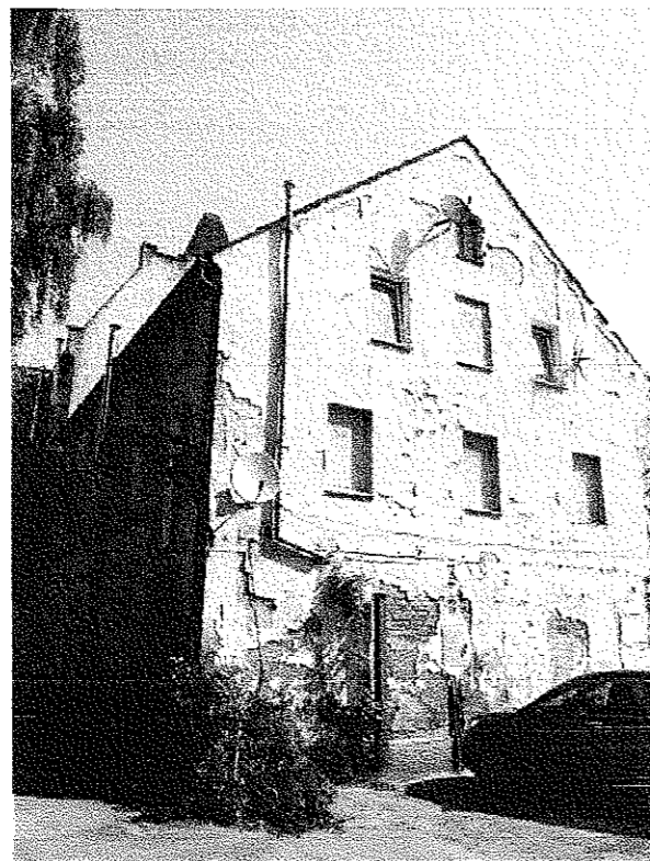
Zdjęcie nr 3 – Elewacja boczna
