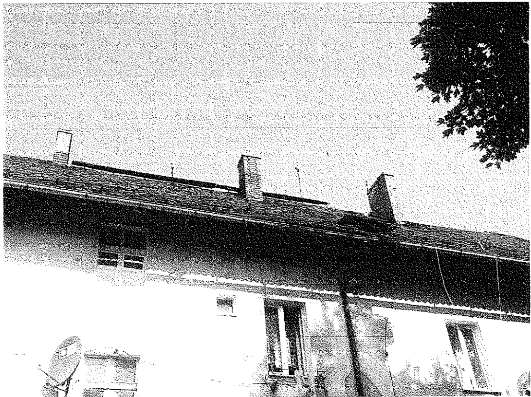
Zdjęcie nr 1 – Dach od strony podwórza
