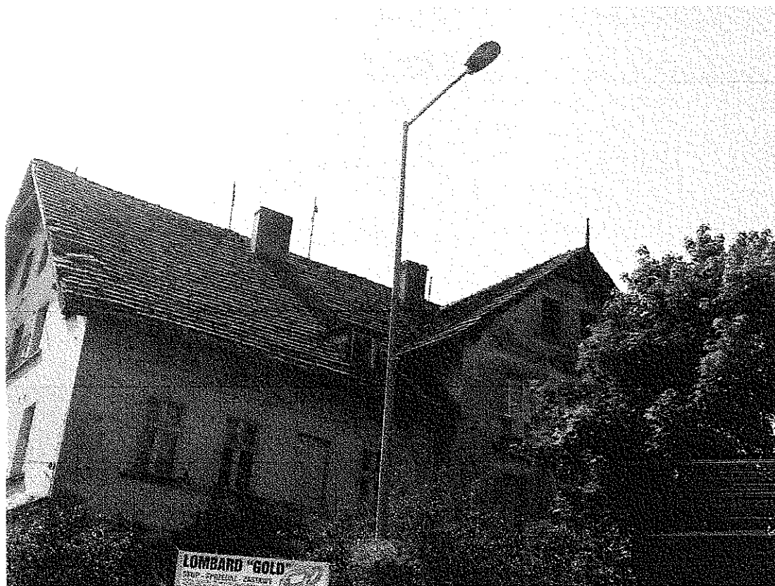
Zdjęcie nr 2 – Dach od strony ulicy
